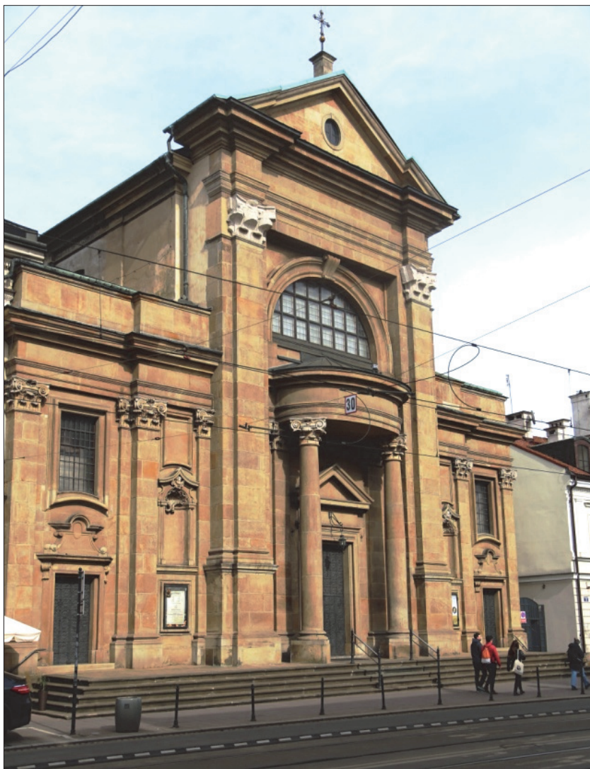
Il. 5. Obecny widok fasady kościoła pw. Nawrócenia św. Pawła Apostoła w Krakowie
