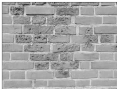
Ryc. 4. Przykład wymiany cegieł na kościele Ścięcia św. Jana Chrzciciela w Chojnicach
