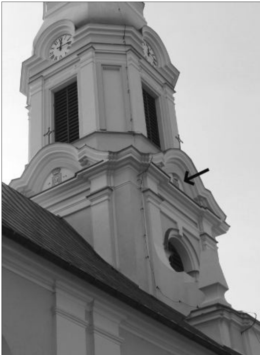
Rys. 7. Widok fragmentu wieży, na którym zaznaczono umiejscowienie herbu. Od strony dachu kościoła inicjały ks. Maksymiliana (stan z maja 2019 r.).
