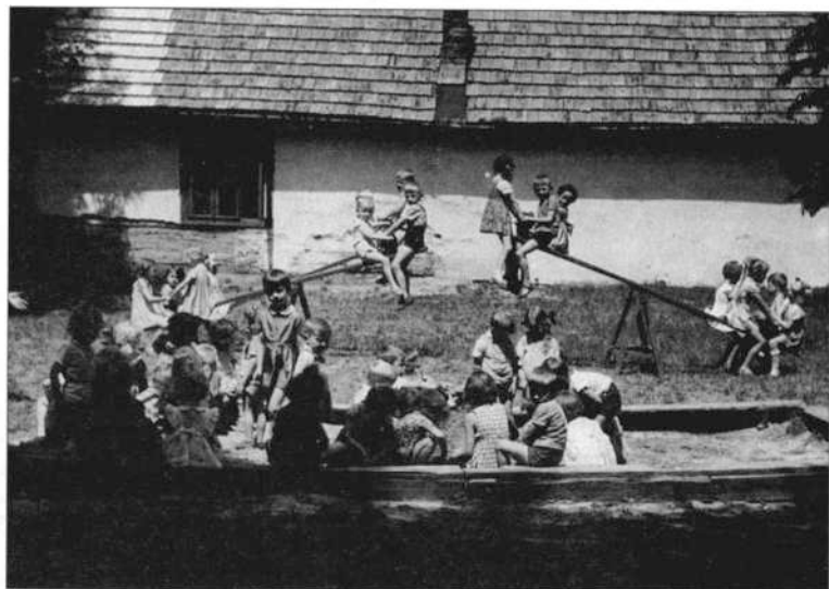
Plac zabaw przy budynku ochronki (lata 30-te)
