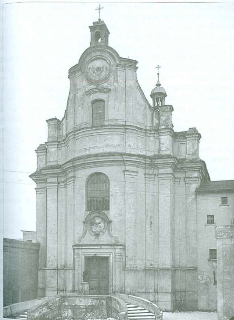
Rawicz. Kościół reformatów pw. św. Antoniego. Fasada. Fot. ze zbiorów PSOZ w Poznaniu
