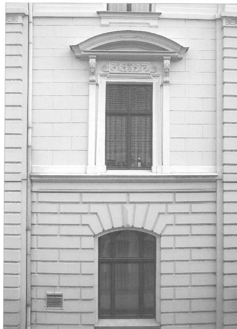
D. „nowe” kolegium jezuickie w Bydgoszczy. Fasada, stan obecny, okna jednego przęsła
