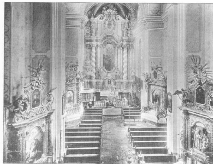
Kościół jezuicki, wewnątrz, widok w kierunku wsch. (MWB)
