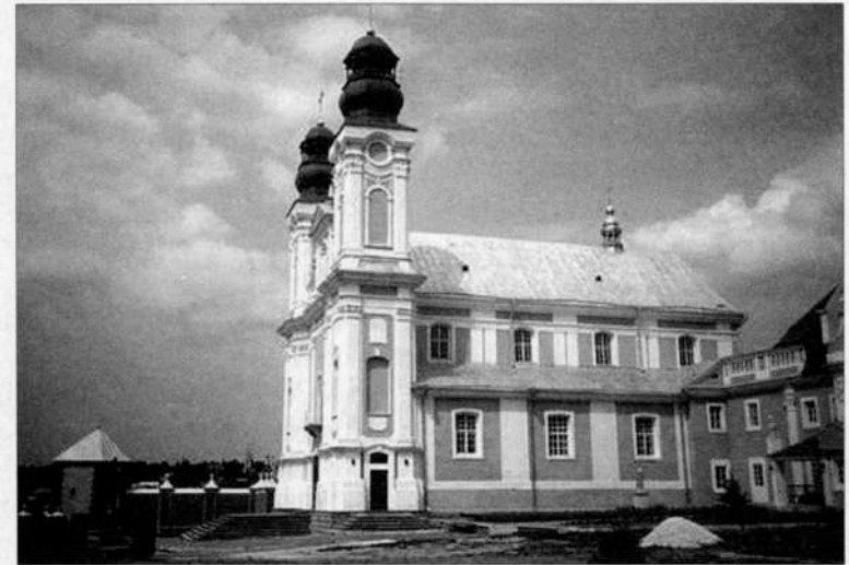
2. Murafa, kościół poddominikański, widok ogólny (fot. autor, 1998)
