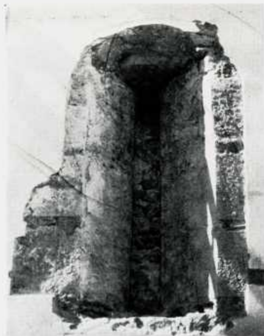
Ryc. 12. Romańskie okno szelinowe w prezbiterium kościoła w Tropiu w trakcie odsłaniania w r. 1965. Fot. S. Koziel.
