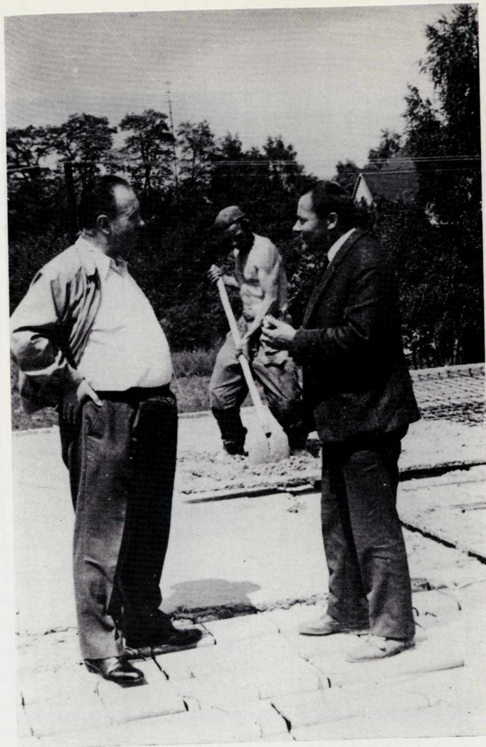
54. Ks. Schletz na budowie nowego domu przy ul. Strzelnicza 6 w rozmowie z inż. A. Freyerm
