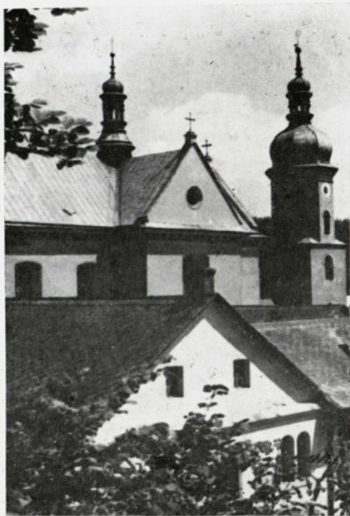
3. Klasztor w Czernej od strony południowo-zachodniej
