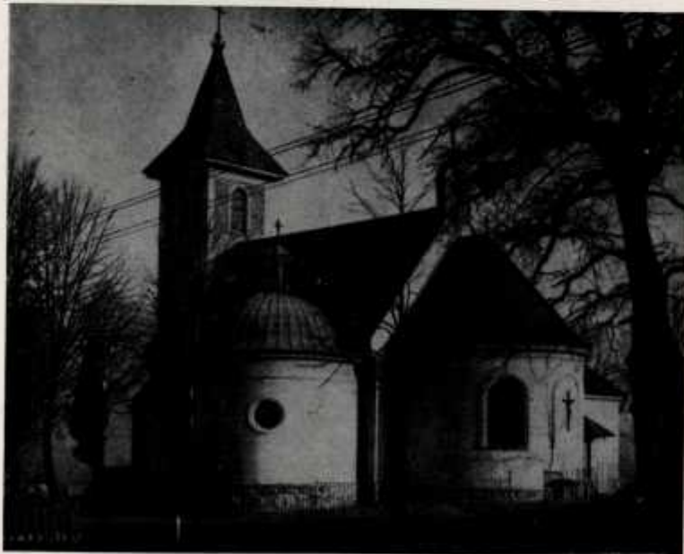
13. Murowany kościół w Zakrzowie z r. 1935
