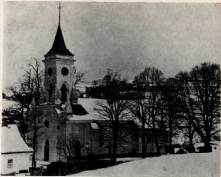
12. Murowany kościół w Stryszowie z r. 1742, rozbudowany w latach 1840—41
