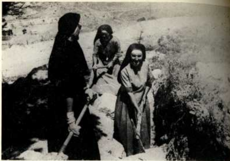
77. Siostry przy kopaniu fundamentu pod Dom Pokoju — Sierociniec na Górze Oliwnej.
