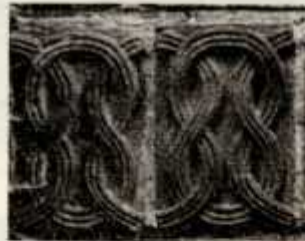
22. Sandomierz, kościół dominikanów, fragment fryzu cokołowego
