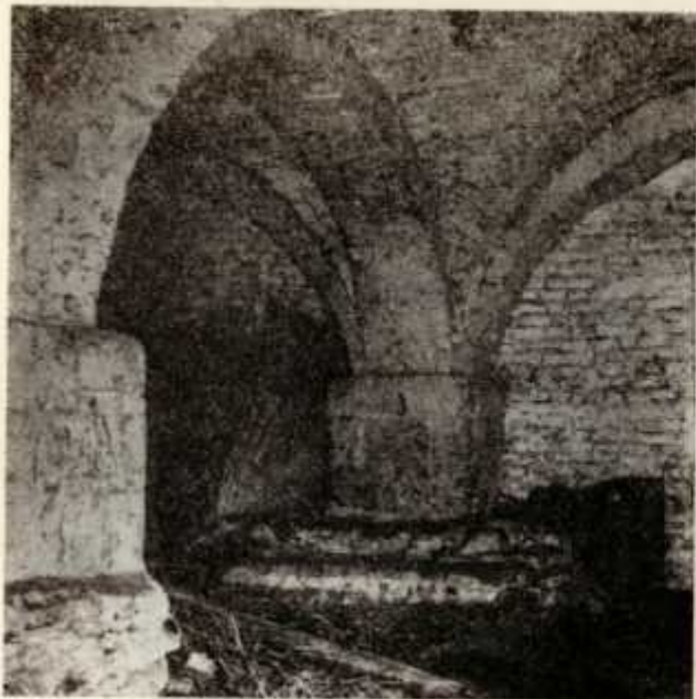
3. Kraków, klasztor dominikanów, fragment piwnicy pod refektarzem
