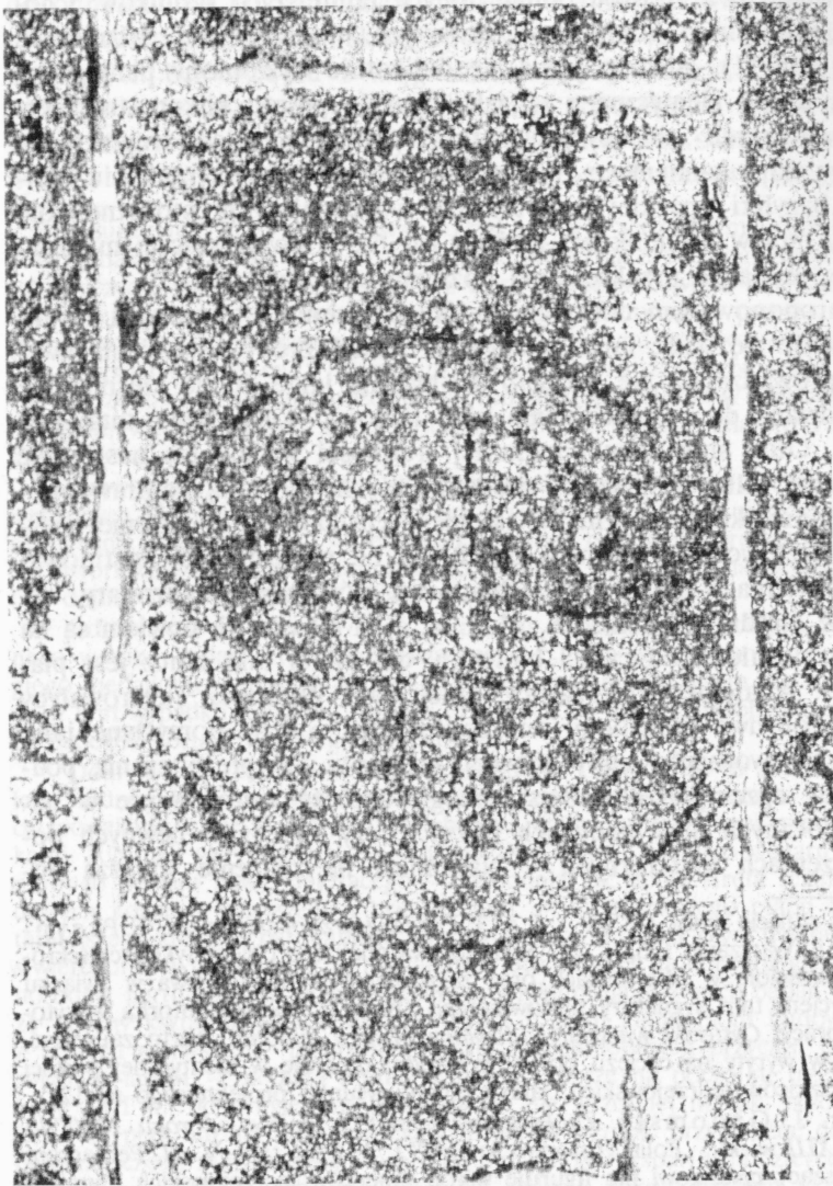
Il. 13. Sulisławice, kościół par. Narodzenia N. P. Marii: rysunek krzyża greckiego zawartego w kolistym medalionie, wyryty na zewnętrznym licu północnej ściany nawy. Fot. T. Kazmierski.
