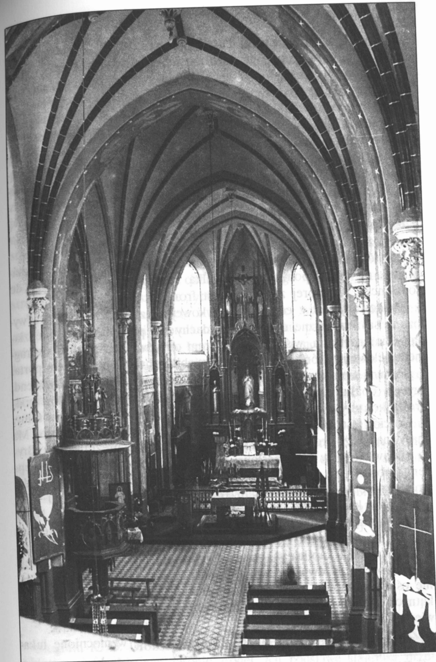
Mełgiew. Kościół parafialny pw. św. Wita. Wnętrze. Widok na nawę główną i prezbiterium. Fot. Elżbieta Podkościelny 1991 r.
