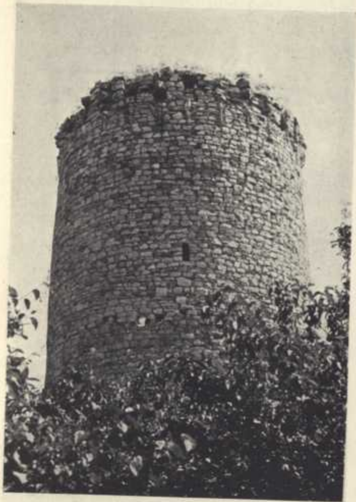
Lipowiec - widok wleży od zachodu (od strony dziedzińca)
