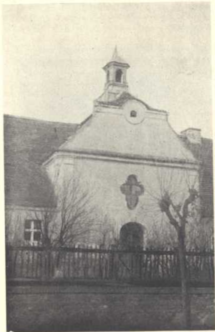
Szpital Św. Łazarza w Trzemesznie
