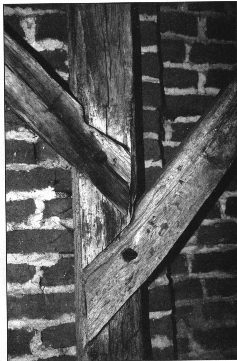
8. Połączenie zastrzałów ze storczykiem – zachodnia partia więzby korpusu nawowego. Fot. Aleksander Jankowski.
